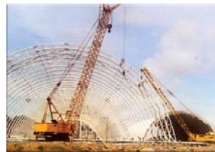
Chế tạo và lắp dựng nhà vòm khẩu độ 58m Nhà máy xi măng Sao Mai - Kiên Giang Long Xuyên
