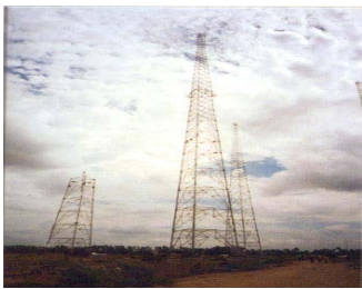
Chế tạo và lắp đặt cột phát sóng và phát thanh Nam Bộ Mỹsông Ba Hạ
