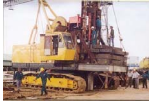
Ép cọc bê tông cốt thép nhà máy nước Long Xuyên
