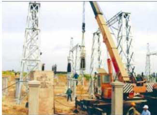
Lắp đặt trạm điện 110kV Nhà máy thủy điện Srock Phu Miêng Nhà máy sơn ICI- Mỹ Phước -Bình
