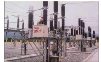
Lắp đặt trạm biến áp 110KV - Nhà máy thủy điện Sông Hình SAOMAI
